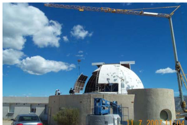
démontage de la coupole du laser-Lune
