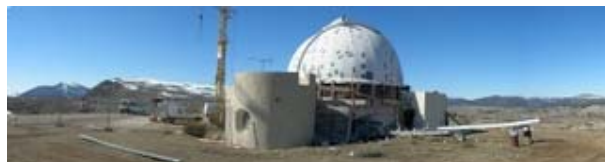
Opération Bâtiment T2000
